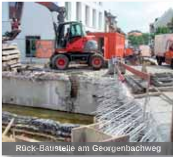
Rück-Baustelle am Georgenbachweg
