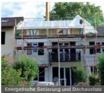
Energetische Sanierung und Dachausbau
